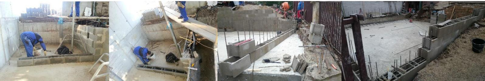
2. Verlegung den einzelnen Wandsegmenten an Bodenstützen und Lasereinstellung in 0,1 mm
