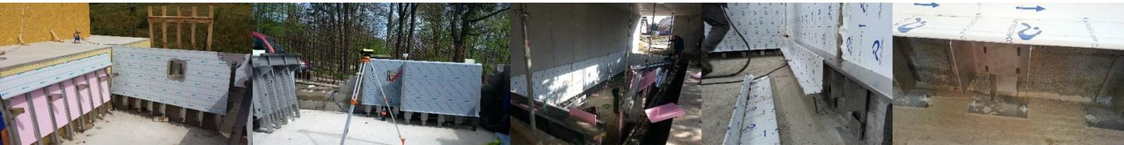
3. (zweite) Betonierung des Beckenbodens, Verschweißung des Becken, Satinieren den Schweißnähten, Dichtheitsprüfung.
